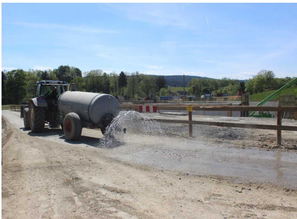
Fot. 6. Zraszanie pyłących powierzchni dróg (poz. 89 PZŚ).
