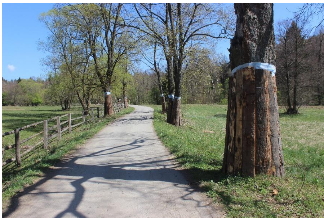
Fot. 12. Zabezpieczone pnie drzew nieprzeznaczonych do wycinki na Terenie Budowy (poz. 20 PZŚ)
