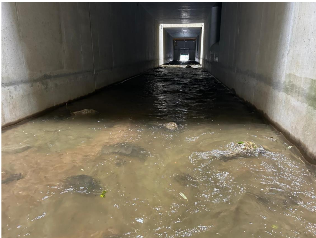
Fot. 19. Sztolni pod zaporą zbiornika – widoczne posadowione kamienie w dnie (poz. 58 PZŚ).
