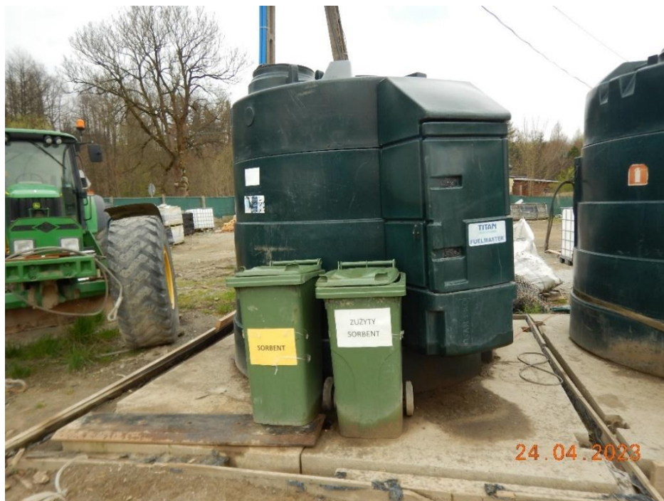
Fot. 5. Punkt tankowania pojazdów na zapleczu budowy - zabezpieczony od podłoża i wyposażony w sorbent (poz. 80 PZŚ).
