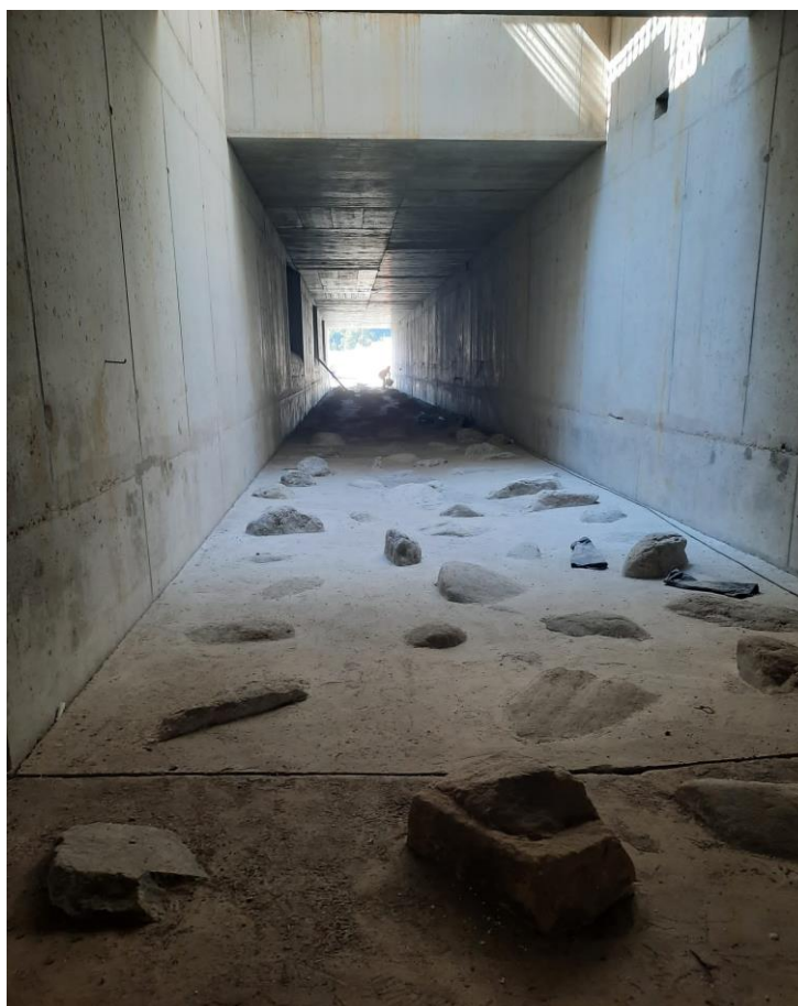
Fot. 18. Sztolni pod zaporą zbiornika – widoczne posadowione kamienie w dnie (poz. 58 PZŚ).
