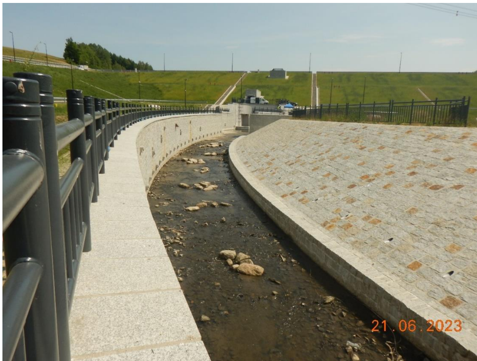
Fot. 17. Odtworzenie struktury dna nowego koryta Nysy Kłodzkiej poprzez rozmieszczenie w dnie dużych kamieni (poz. 58 PZŚ).
