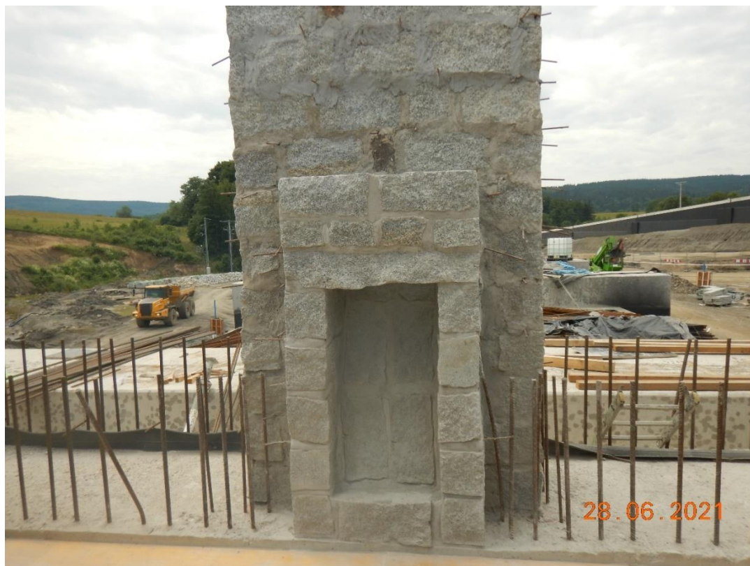
Fot. 11. Instalowanie komór dla nietoperzy w kominach sztolni zapory zbiornika.
